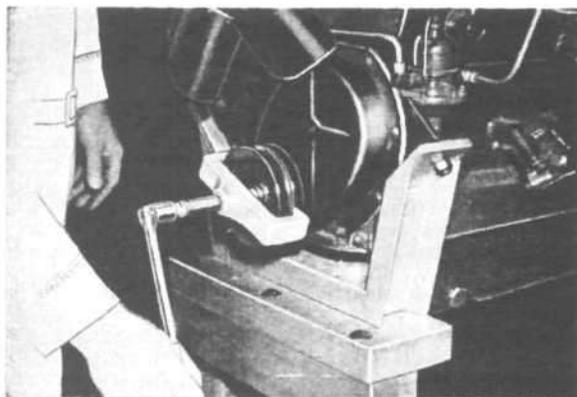
FIG. 105—CRANKSHAFT PULLEY PULLER
