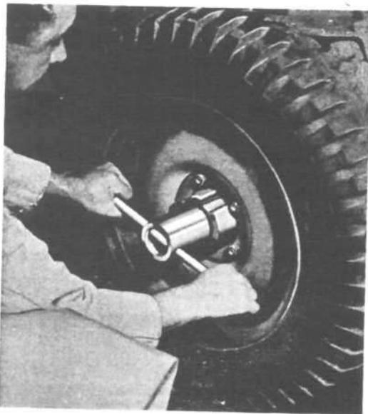
FIG. 229—WHEEL BEARING NUT WRENCH
