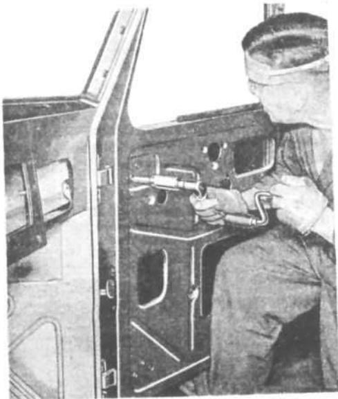
FIG. 303—DOOR HINGE ADJUSTMENT
